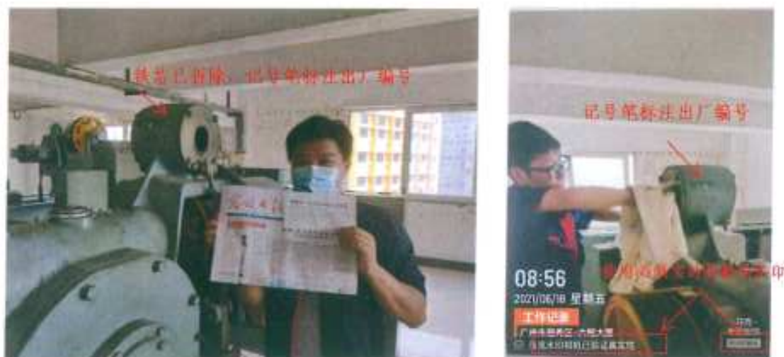
图 1 制动器拆解后的驱动主机照片（报纸或防篡改水印）
